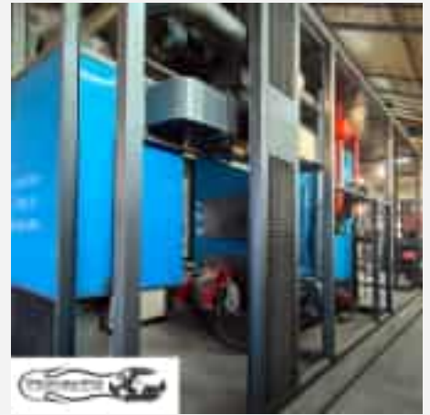
Mobilna kotłownia kontenerowa MAC 700 - 1250 kW firmy Płomex-Pol w trakcie montażu
